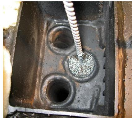
Der Zusammenbau erfolgt in umgekehrter Reihenfolge. Achten Sie darauf, dass sich das Reinigungsgestänge nach der Montage wieder leicht bewegen lässt.
