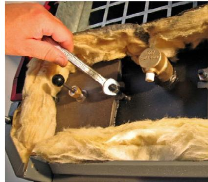
Reinigungsdeckel mit Gestänge und Reinigungspiralfedern vorsichtig nach oben herausziehen. Auf richtige Einbauposition achten! Deckel so zur Seite legen, dass sich die Federelemente nicht verhaken.
